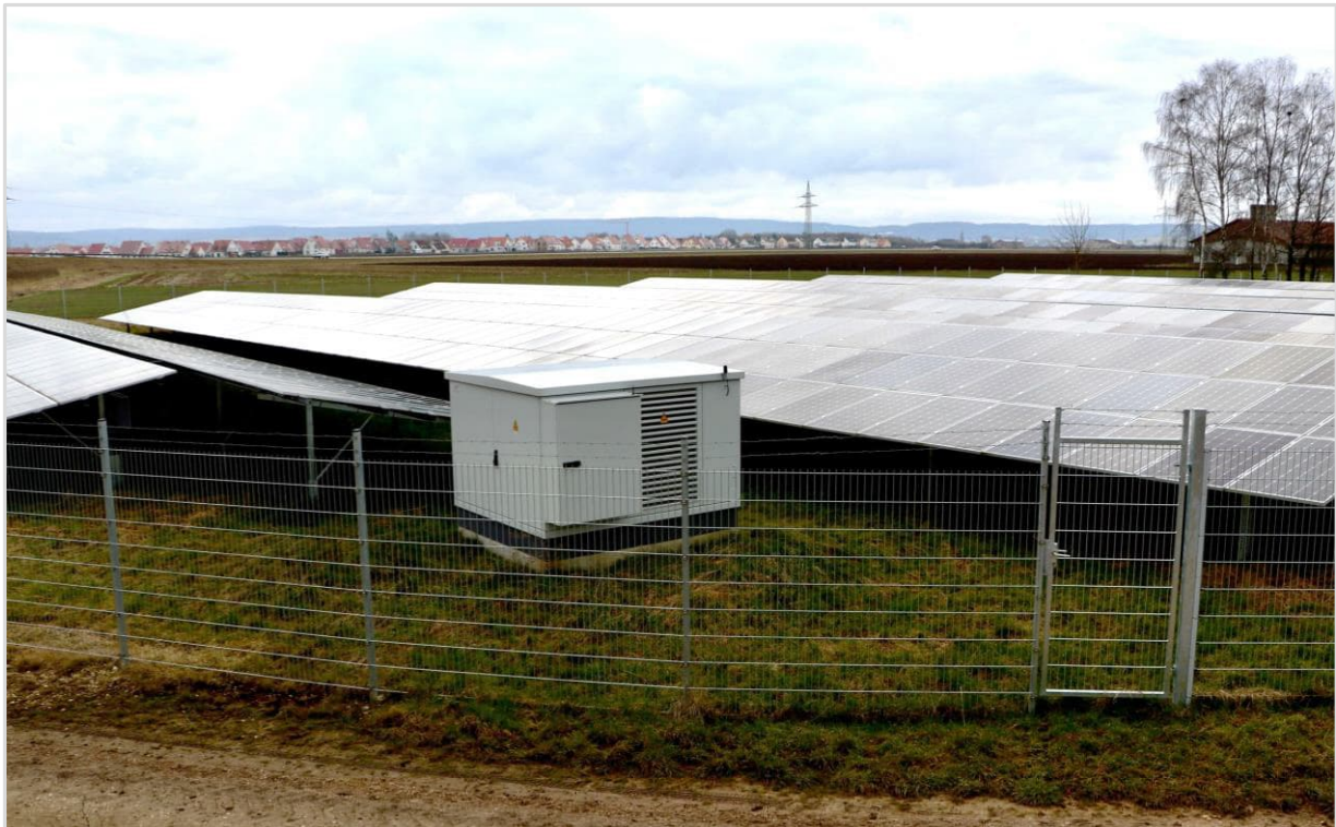
Abbildung 9: Relativ niedrige und dichte, dachartige Aufstellung der Modulreihen in Ost-West-Ausrichtung (© Baader Konzept)
