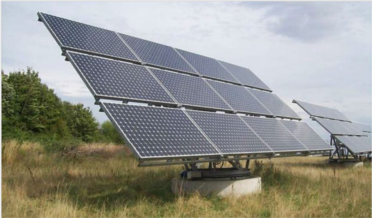
Abbildung 5: Nachgeführte Anlage (2-achsig), Gründung mit Betonfundament, weiter Stand, deutliche Modulabstände (Quelle: Photovoltaikforum GmbH www.photovoltaikforum.com , abgerufen am 18.01.2023)
