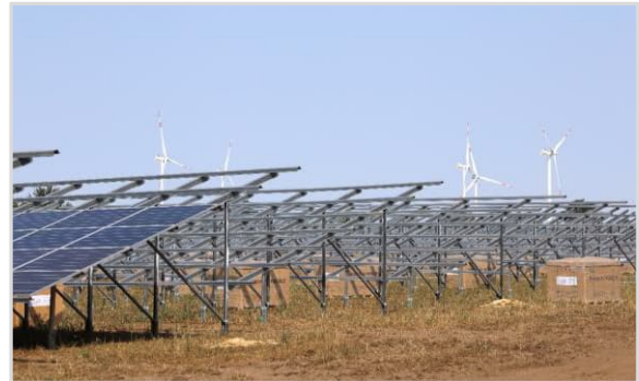
Abbildung 34: Montage der Solar-Module (© F. Steinmann, LLUR)
