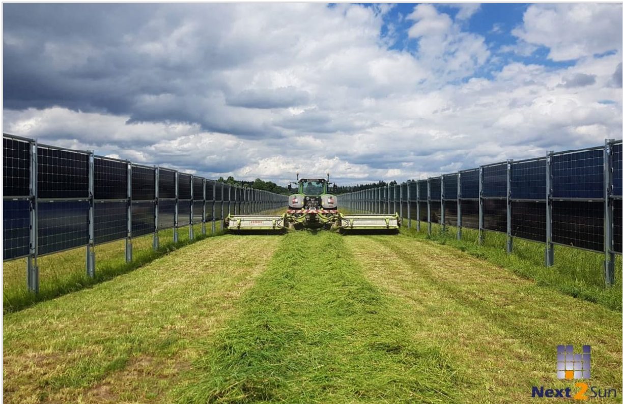
Abbildung 11: Senkrechte Aufstellung bifacialer Module in Ost-West-Ausrichtung – Form der Agri-Photovoltaik (Quelle: www.next2sun.de , abgerufen am 19.01.2023)
