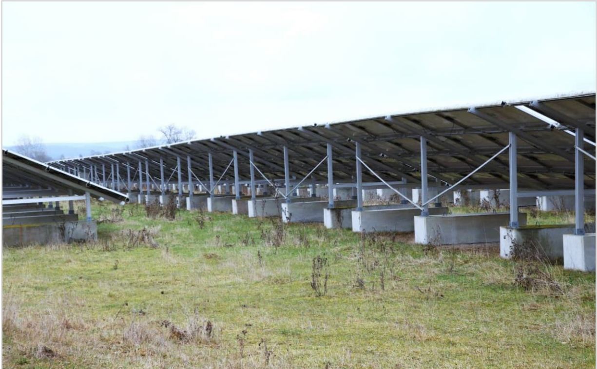
Abbildung 7: Starre Reihenanlage – Gründung mit Betonfundamenten (schwimmend) (© Baader Konzept)
