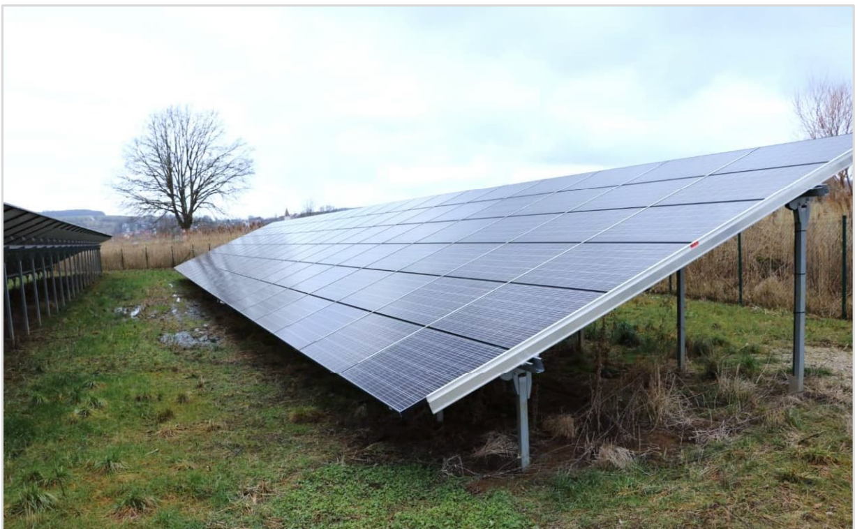
Abbildung 8: Starre Reihenanlage – Gründung mit Rammpfählen aus verzinktem Stahl (© Baader Konzept)
