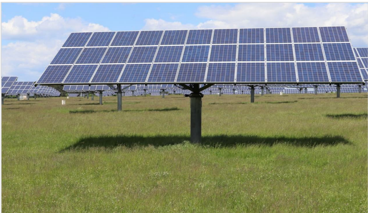
Abbildung 6: Nachgeführte Anlage (2-achsig), Gründung mit Schraubanker, weiter Stand, geringe, vertikale Modulabstände (© Baader Konzept)
