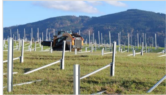
Abbildung 32: Einsatz eines kleinen, leichten Raupenfahrzeugs zum Transport der Trägergestelle (© Schnittstelle Boden)
