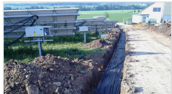
Abbildung 36: Erdkabeltrasse einer Photovoltaik-Freiflächenanlage (© Franke Elektrotechnik GmbH www.solarstrom.de )
