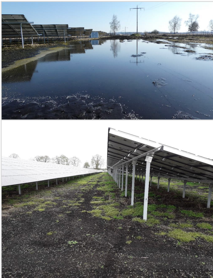
Abbildung 21: Photovoltaik-Freiflächenanlage auf einem wiedervernässten Moorstandort (2021) (© Bayerisches Landesamt für Umwelt)
