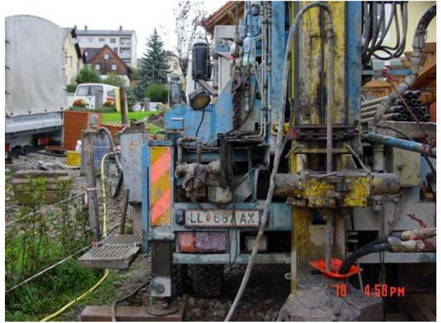
Abbildung 10, Verpressung mittels Verpressgestänge
