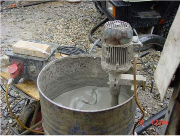
Abbildung 9, Anmischen der Suspension mit Rührwerk
