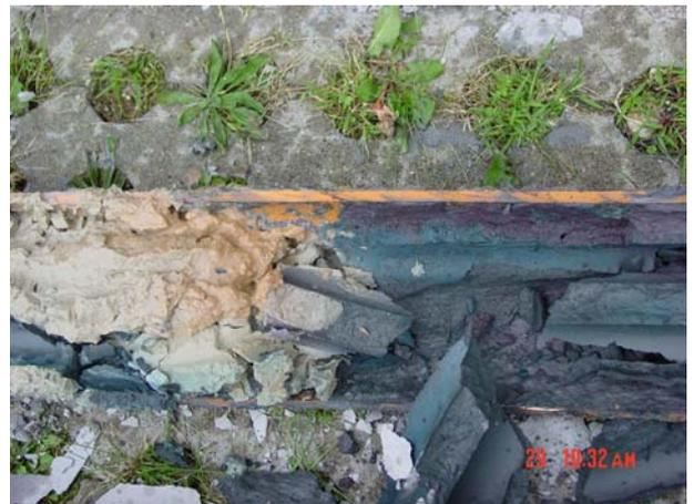
Abbildung 24, Detail Übergang Suspension- Bentonit
