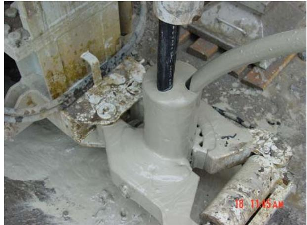
Abbildung 8, Austreten der Suspension am Bohrlochmund
