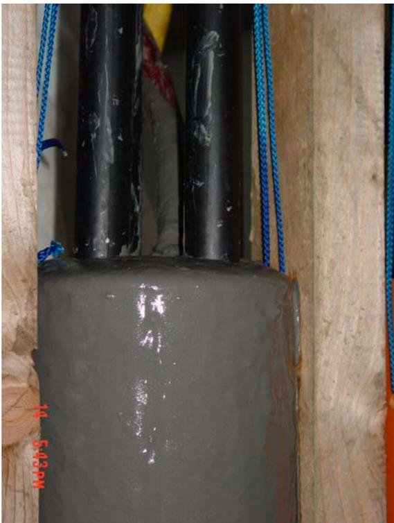
Abbildung 7, Überfließen der Suspension
