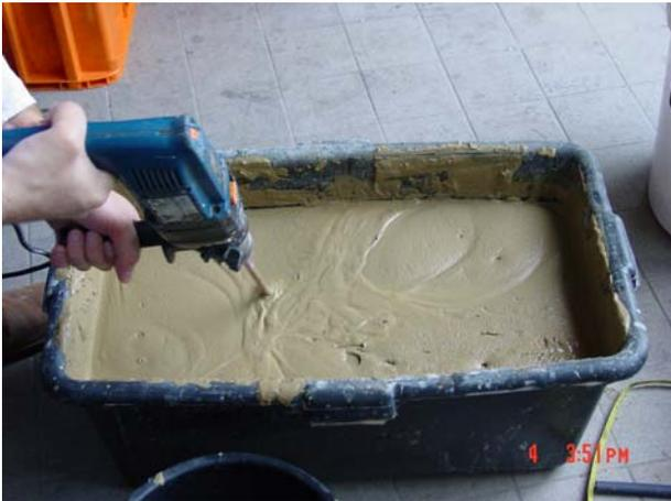
Abbildung 9, Anrühren der Suspension
