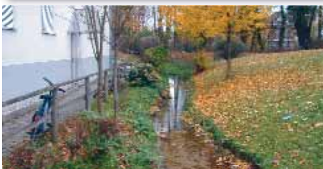
Der kanalisierte Bach wurde im Zuge der Errichtung dieser Wohnhausanlage als naturnahes Gerinne gestaltet.
